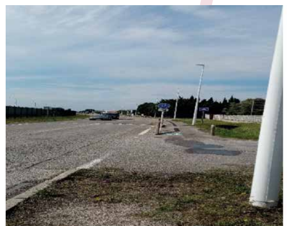
Maintenance éclairage public
