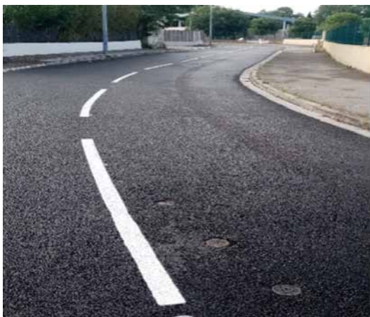
Réfection de la rue des Compagnons, ZAE Cabrau à Saint-Martin-de-Crau
