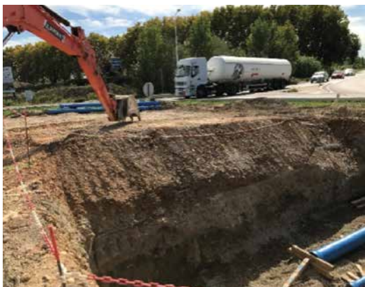
Création d'une plateforme DECI dédiée à l'intervention des pompiers (Parc d'activités de Saint-Martin-de-Crau)
